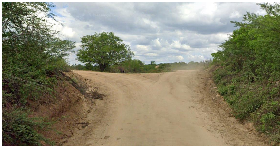
FOTO 8 - EST. 95 – VISTA SENTIDO CRESCENTE DO ESTAQUEAMENTO (EM DETALHE BIFURCAÇÃO COM CONTINUIDADE À ESQUERDA NO TRAJETO DA ESTRADA PROJETADA)
