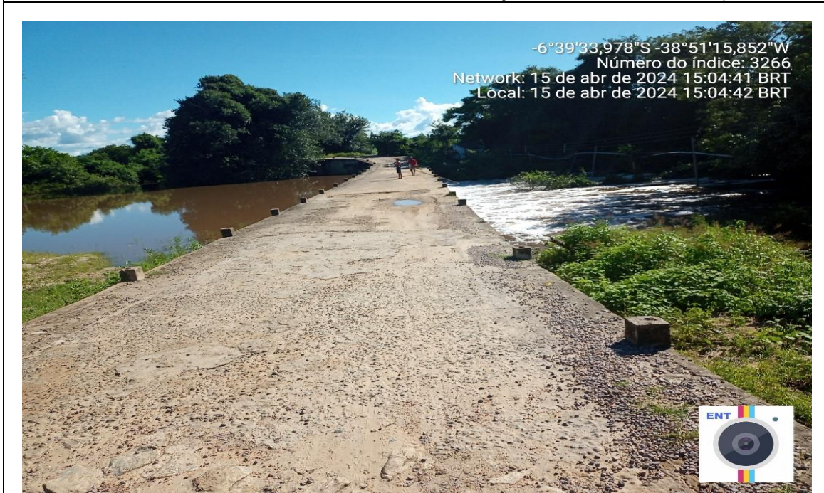
FOTO 14 - EST. 256 – VISTA SENTIDO CRESCENTE DO ESTAQUEAMENTO (EM DETALHE OMBREIRA PASSAGEM MOLHADA DE PASSAGEM – RECUPERAÇÃO DO PISO DE CONCRETO)
