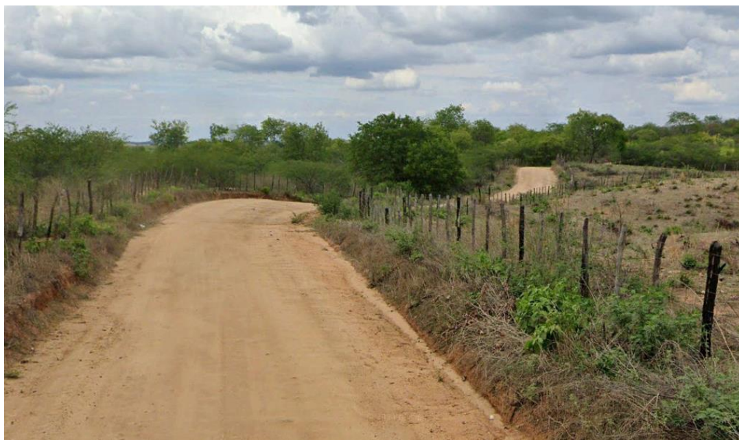
FOTO 11 - EST. 148 – VISTA SENTIDO CRESCENTE DO ESTAQUEAMENTO (EM DETALHE TALVEG)
