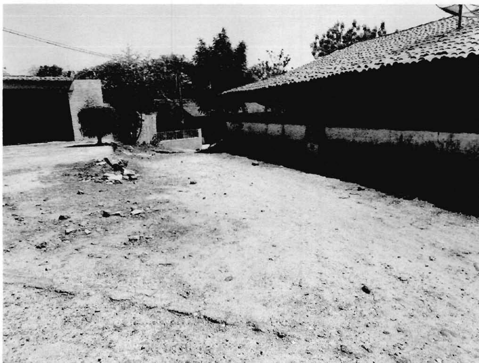
Figura 25 - RUA ZITO LOBO - ALEM RIO - SEDE
