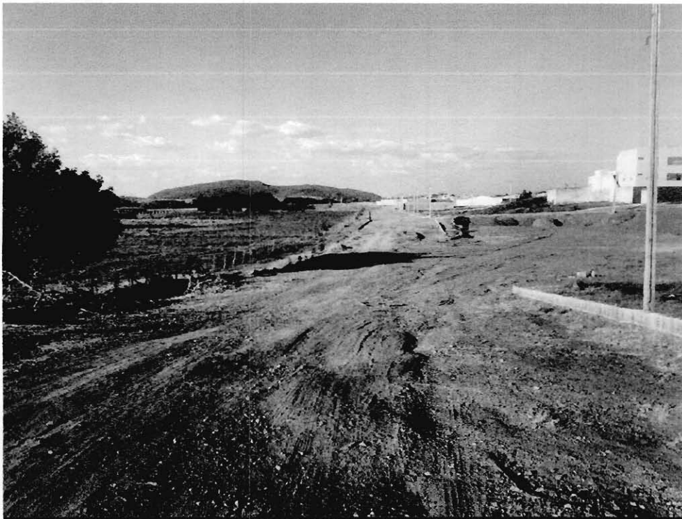
Figura 16 - AVENIDA INÁCIO ALVES DE SOUSA - BELA VISTA - SEDE
